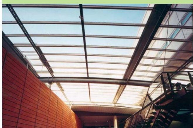
EUDIL, Villeneuve-d'Ascq (59), Trace architecte (59), sans lames brise-soleil
