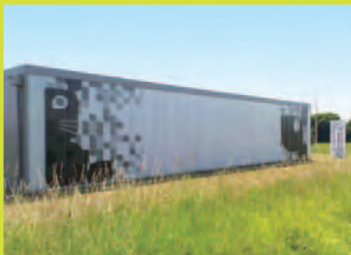
Clinique vétérinaire à Pont l'Abbé d'Arnault (17) Architectes : Virginie Gravière et Olivier Martin. Adhésifs collés sur Danpalon (T Dec).
