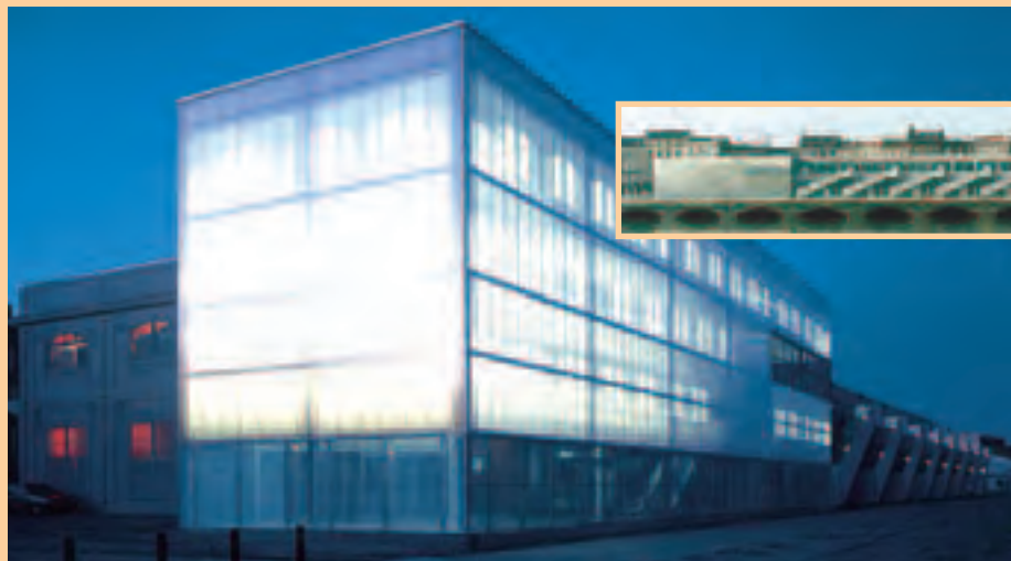
Hangar 14, salle d'exposition, Bordeaux. Architectes : C. Gautié, V. Tastet, S. Courrian, J.P. Lanoire.
