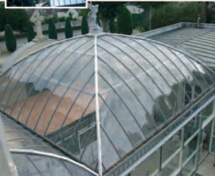
Lycée Haute Follis - Laval (53) - Architecte : Agence Belaud.
