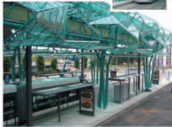
Gare de tramway d'Hérouville-Saint-Clair Cabinet d'architecture et de design Tetrarc.
