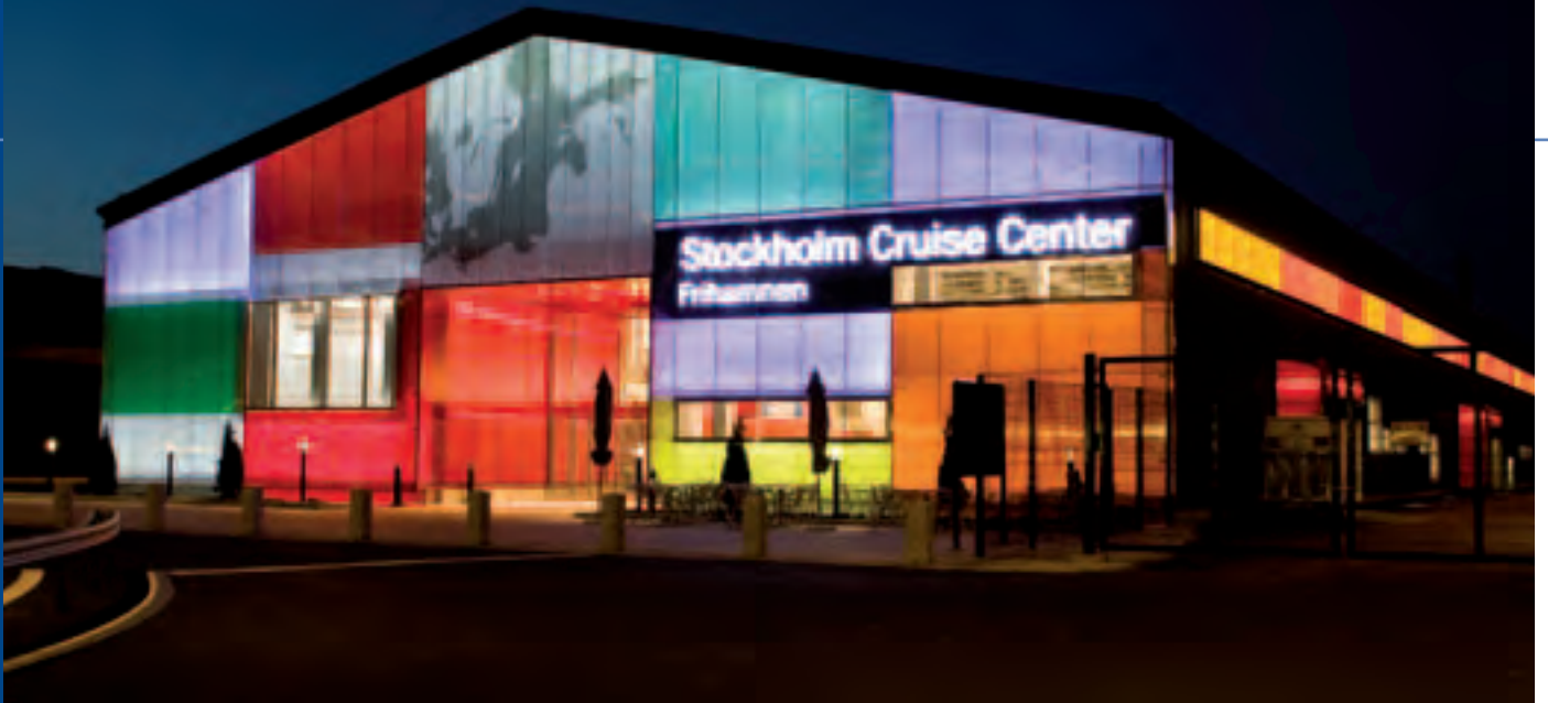
Stokholm Cruise Center - Architecte : Studio 1.11 Architects AB - Joakim Schiött.
