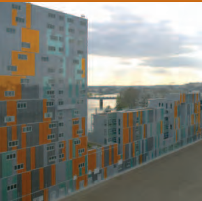
Bureau et résidence Marcel Saupin à Nantes (44) - FGP architectes.
