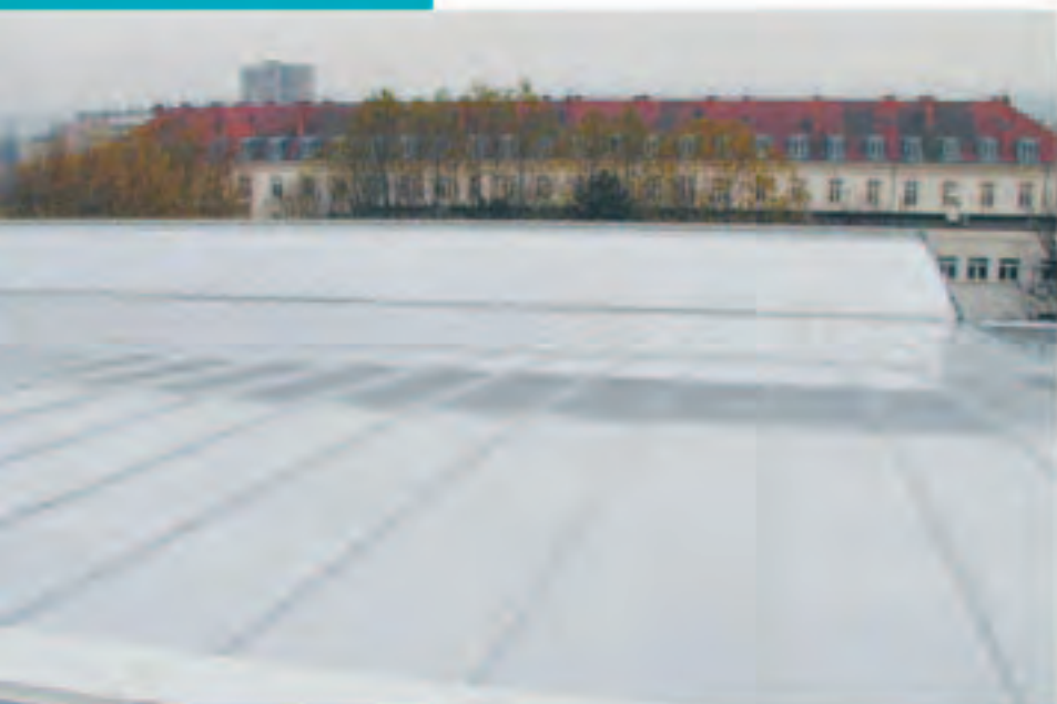
Caserne Duhesme à Mâcon Architecte : Dominique Péloni.
