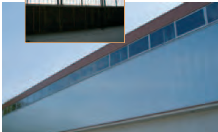
Gymnase Desmet à Clichy Sous Bois, (93) - Agence Carril
