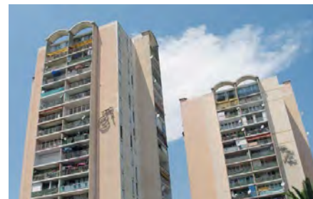
AVANT LA RÉHABILITATION
