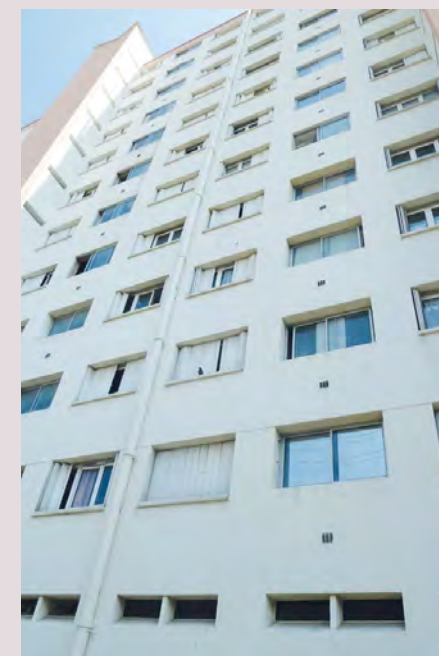
AVANT LA RÉHABILITATION
