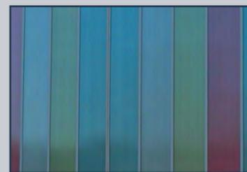
C'est une idée simple mais au résultat spectaculaire : colorer les brise-soleil intégrés dans le Controlite® permet d'obtenir une façade qui change en fonction de la luminosité et de l'inclinaison des lames verticales. C'est ce qui a été appliqué pour la rénovation et l'extension du gymnase du lycée Thomas Corneille à Barentin.
