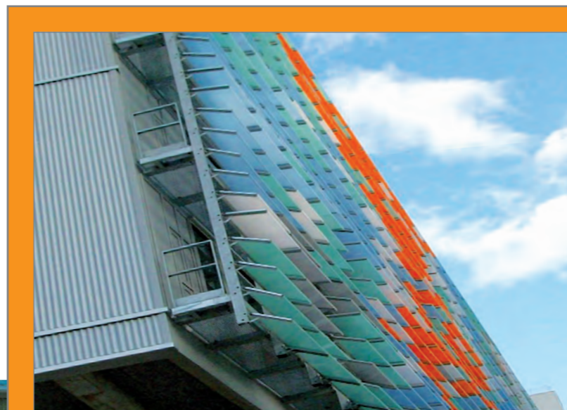
Entreprise de pose : Bardage : AXIMA à Nantes (44) - Tél. : 02 40 32 49 90 - Brise-soleil : ATELIERS DAVID à Guérande (44) - Tél. : 02 40 24 90 34 Façade Nord : 4400 m² Bardage rapporté Danpalon 16 MC 1040 Alu, Vert, Gris, Orange, Opal, Rouge - Façade Sud (Brise-soleil) : 2500 m² Danpalon Bleu, Cristal, Gris, Orange, Vert.
