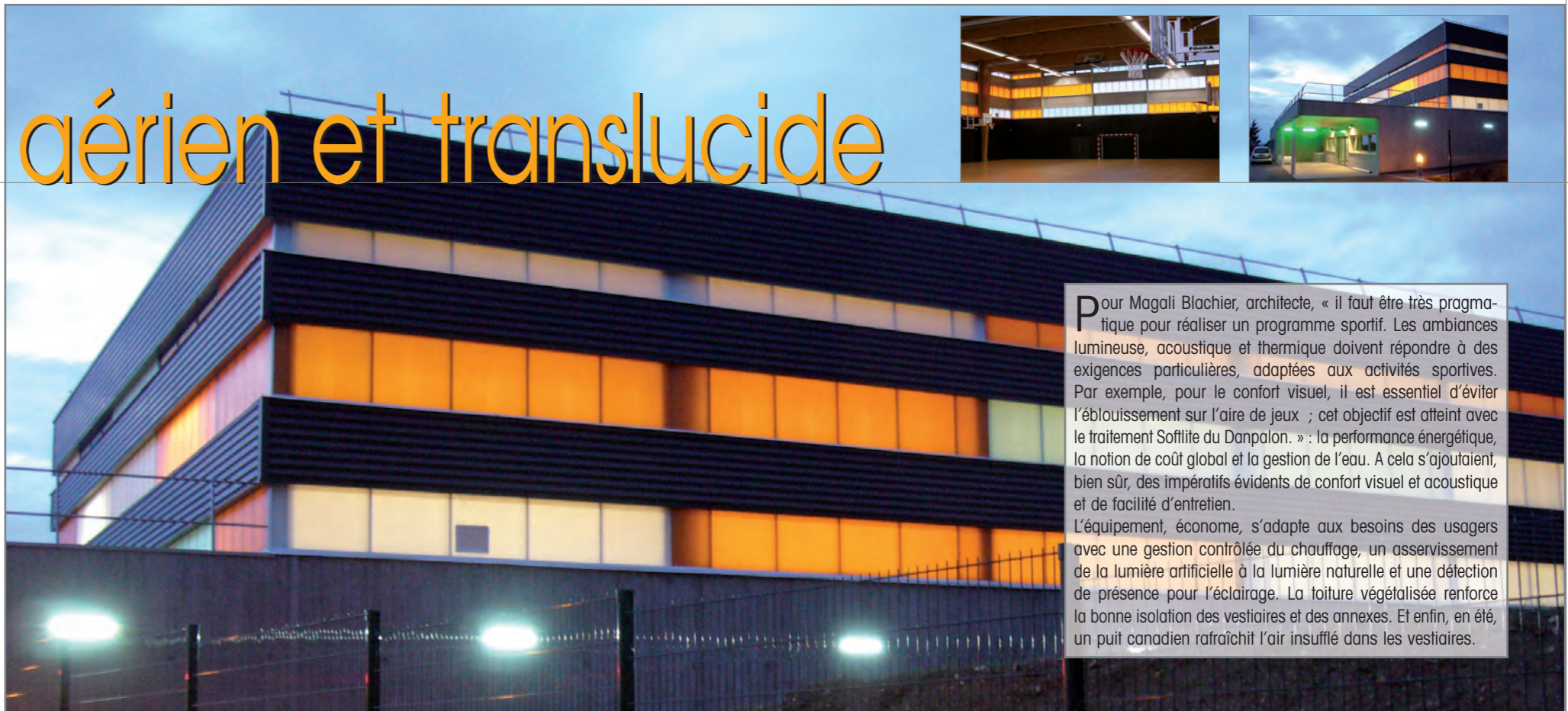
Entreprise de pose : MARTIN G à Pont Evêque (38) - Tél.: 04 74 16 17 77 - Bardage Danpalon 16 MC 600 Cristal Sofflite et 1040 Cristal, 600 et 1040 Vert Sofflite et Orange.
