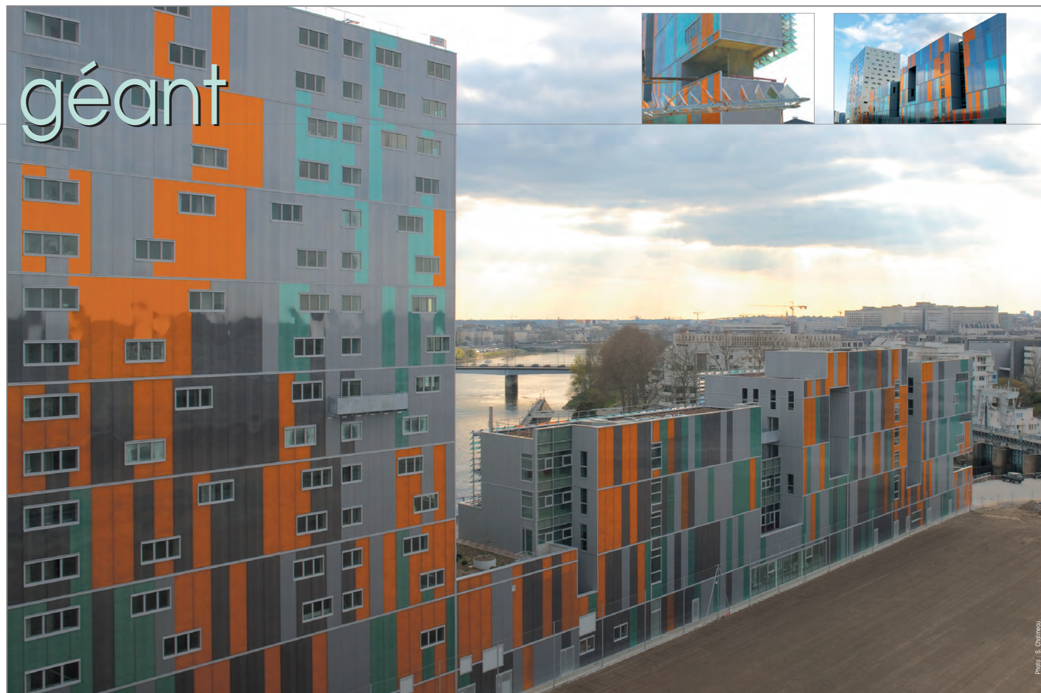
Entreprise de pose : Bardage : AXIMA à Nantes (44) - Tél. : 02 40 32 49 90 - Brise-soleil : ATELIERS DAVID à Guérande (44) - Tél. : 02 40 24 90 34 Façade Nord : 4400 m² Bardage rapporté Danpalon 16 MC 1040 Alu, Vert, Gris, Orange, Opal, Rouge - Façade Sud (Brise-soleil) : 2500 m² Danpalon Bleu, Cristal, Gris, Orange, Vert.
