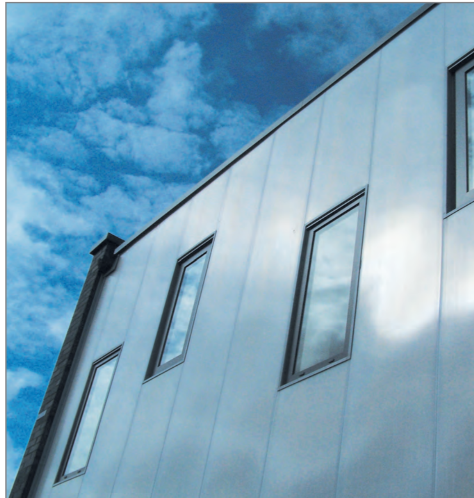
Entreprise de pose : Architectural Products - Londres - bardage et auvent : Danpalon 8 et 10 MC 600 Ice.
