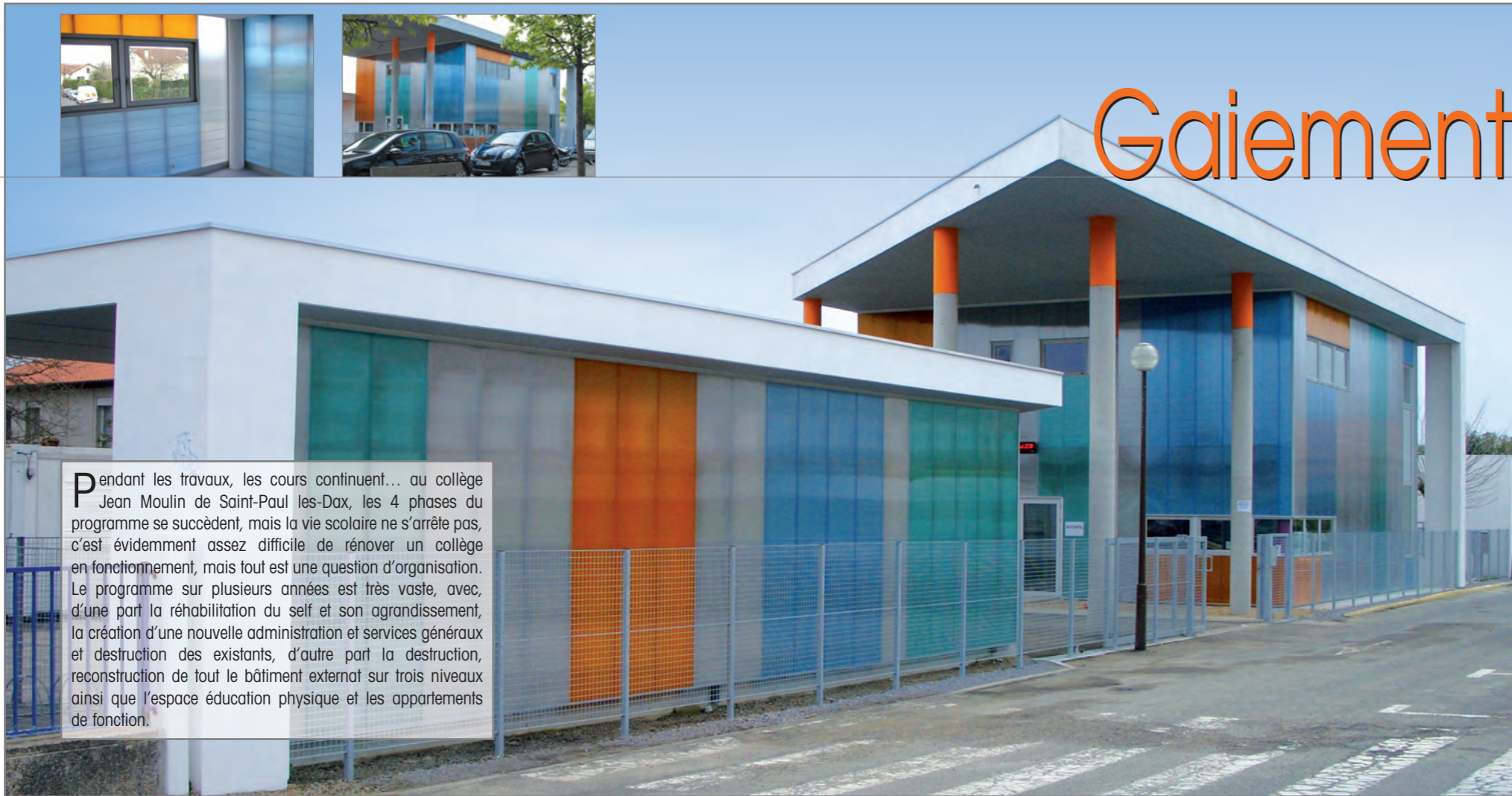
Entreprise de pose : Miroiterie LAPEGUE à Dax (40) - Tél.: 05 58 74 28 74 - Façade Danpalon double sur ossature verticale alu : Danpalon 16 MC 600 Vert, Bleu, Orange, Cristal.
