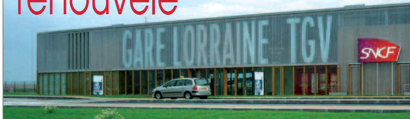
Entreprise de pose Zillhardt-Staub - Bardage Everlight 610 Cristal.
