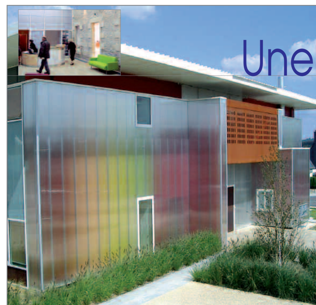
Entreprise de pose : Aluminium de Bretagne - Danpalon 16 MC - 600 mm Cristal.
