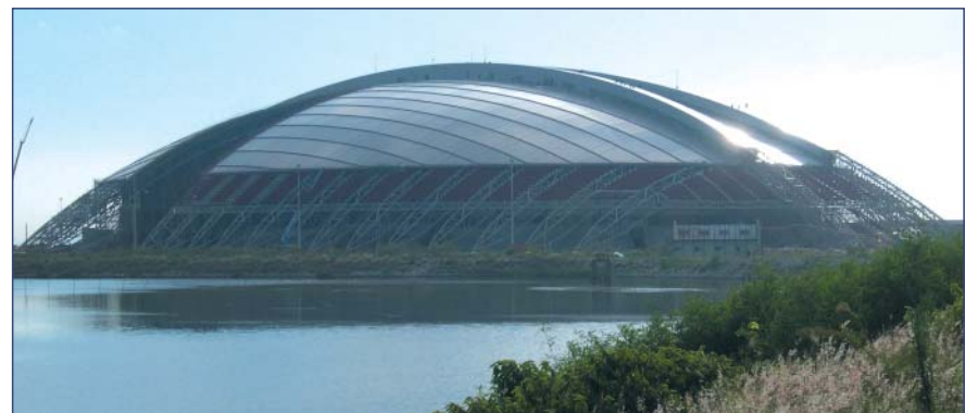
Centre sportif de Macao en cours de construction : 80 000 m 2 de Danpalon
