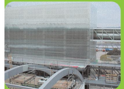
visite destiné au grand public, l'usine devient vitrine. Les matériaux sont déclinés en fonction du process industriel de valorisation des déchets. En partant de l'opaque (fosses à ordures), le projet devient translucide à travers 2800 m² de Danpalon, utilisé dans sa version Opale (au niveau des fours d'incinération) puis Cristal (traitement des fumées) pour aboutir à des structures
