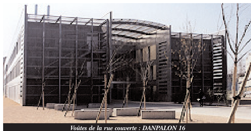
Voûtes de la rue couverte : DANPALON 16
