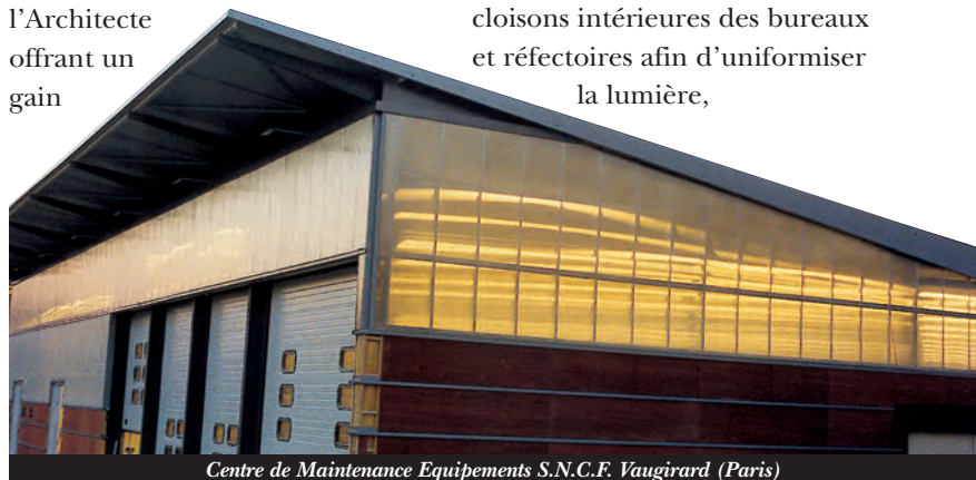
Centre de Maintenance Equipements S.N.C.F. Vaugirard (Paris)
